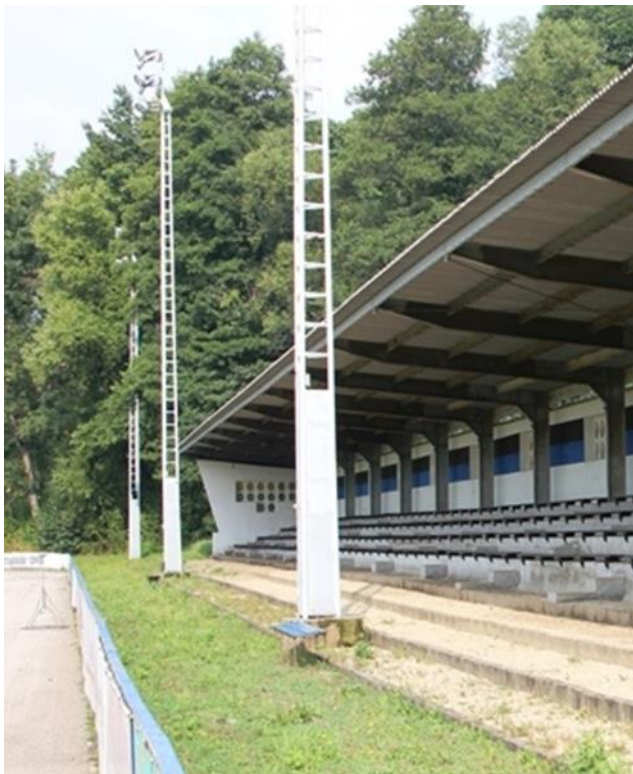
Erstmals fördert das Bundesumweltministerium die Sanierung vereinseigener Sportstätten. (W. Klein)
